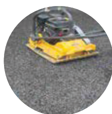
Položení a zhutnění vyrovnávací vrstvy
